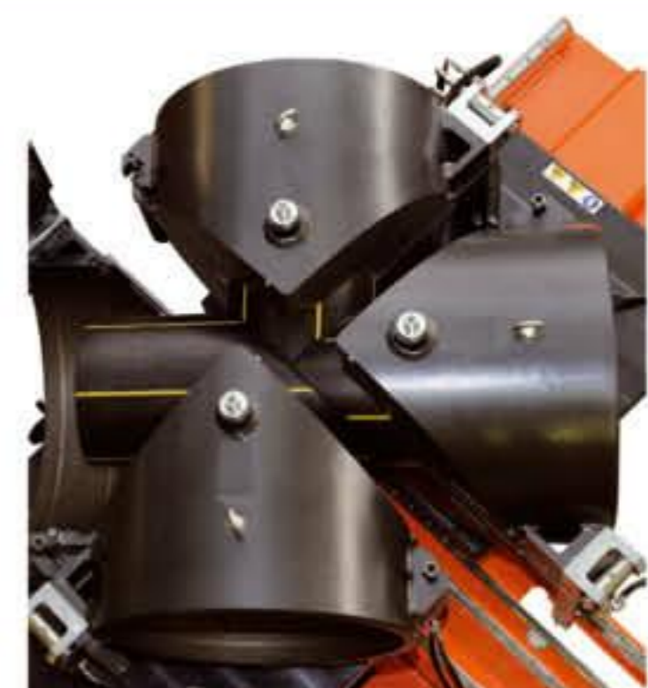
Тройник при сварке
